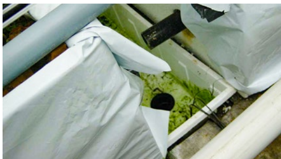
Drainage van een teeltbed
